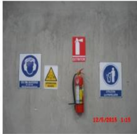
Señales instaladas en la Planta.
